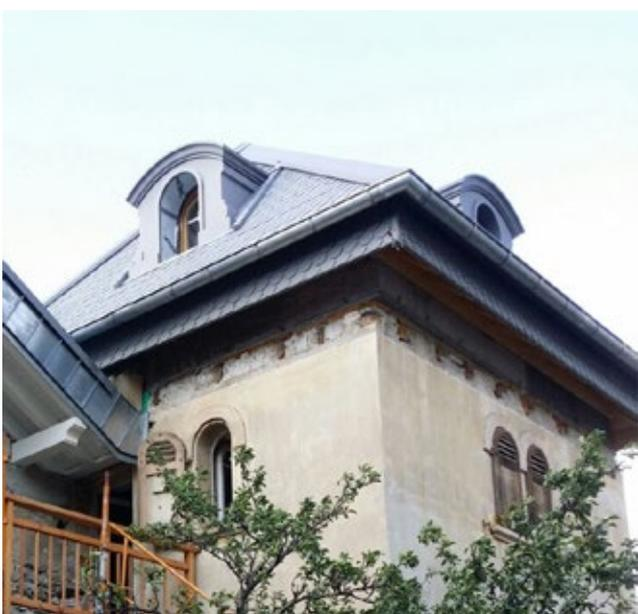
Toute la construction de la toiture, y compris la couverture en écailles et les lucarnes, ont été réalisées sur place, puis posées et fixées directement sur la tour à l'aide d'une grue.
